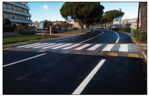
I lavori prevedono l'eliminazione delle criticità rappresentate dalle radificazioni delle alberature, la realizzazione di pozzetti per la raccolta delle acque meteoriche e il ripristino della pavimentazione carrabile con la stesura di conglomerato bituminoso e la conseguente segnaletica orizzontale.
